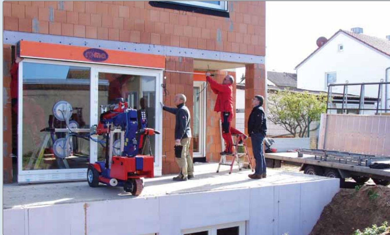
KS Robot bei der Montage einer Hebe-Schiebe-Tür, Fa. Busch Bauelemente, Wahlheim bei Mainz.
