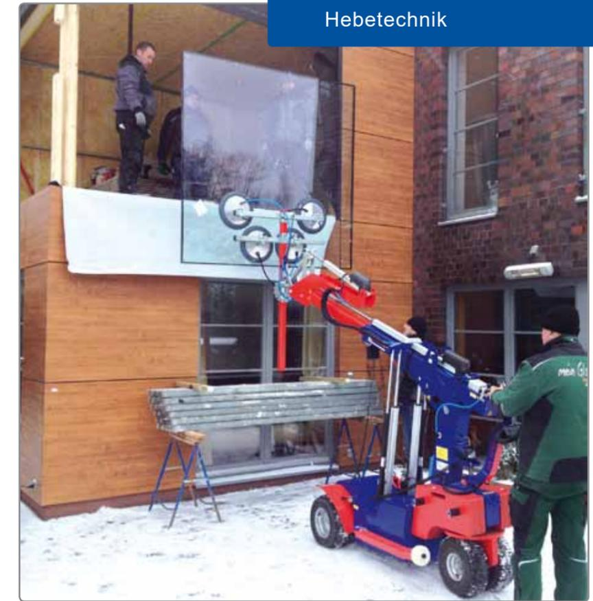
Hochwertige Synchronsteuerung und Fahrtrieb sorgen für sanfte, fließende Bewegungsabläufe. Abb. zeigt KS Robot 400 Offroad.
