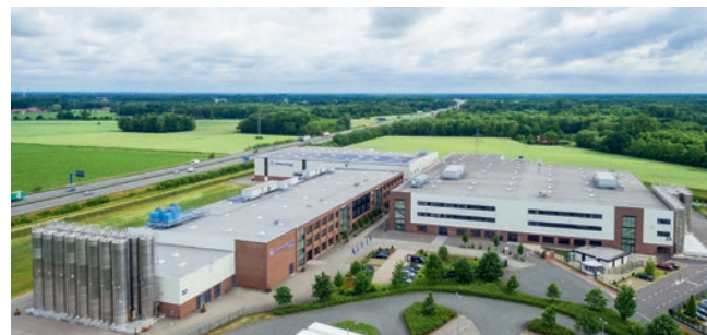
Germany, Plant 3: Pöppelmann GmbH & Co. KG, Lohne/Brockdorf
